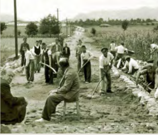
Köy Enstitüsü Öğrencilerinin Yol Yapım Çalışması
